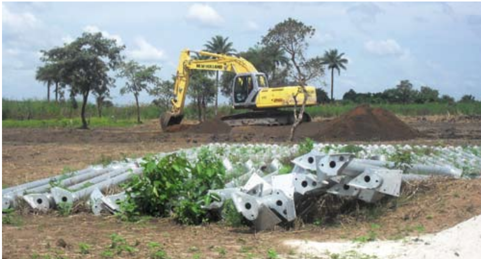
Bauarbeiten für ein Bewässerungssystem auf dem von Addax gepachteten Land in Sierra Leone.
